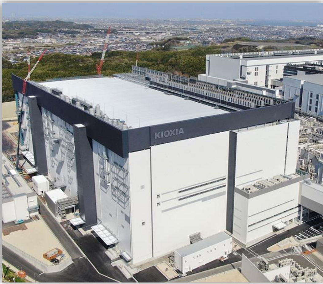
Fab7, usine de Yokkaichi
