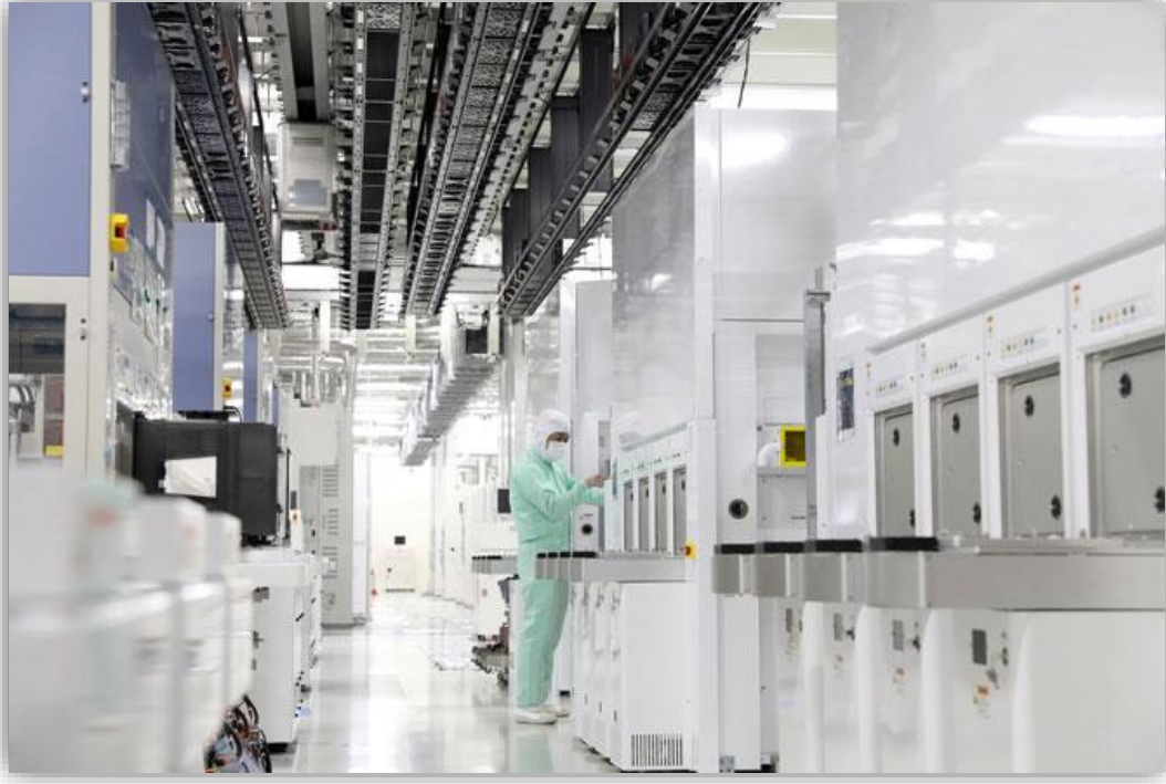
Fab7, Yokkaichi Tesisinin temiz odası
