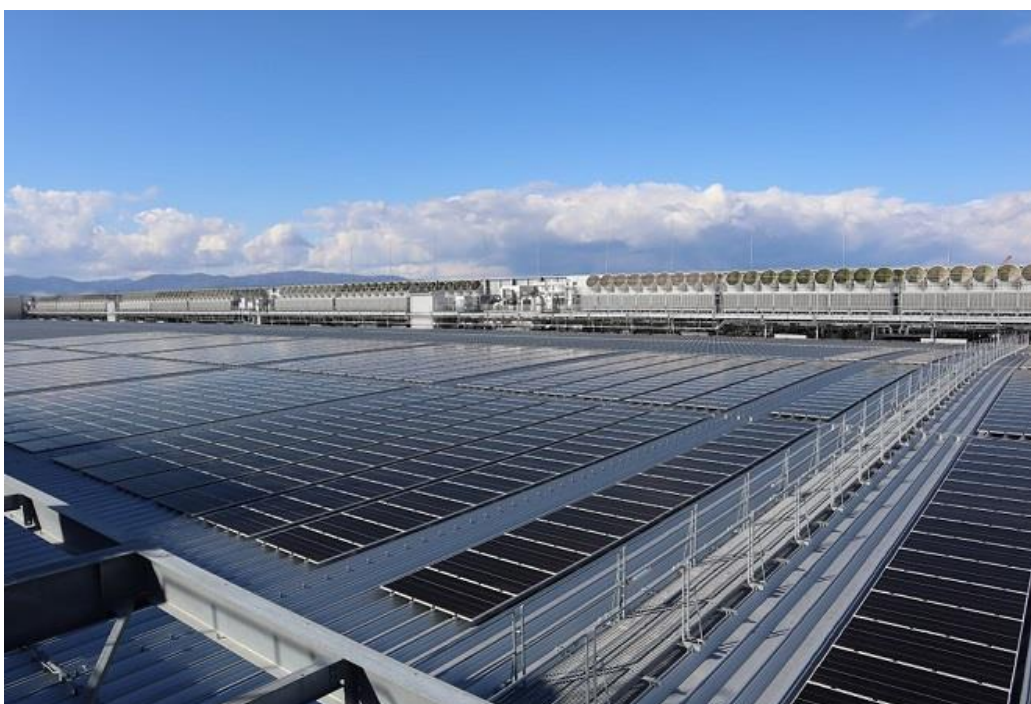
Bildtext: Solpaneler på taket på Fab1-anläggningen i Kitakami
